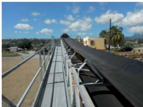
2/ Vue sur le site depuis le haut de l'installation
