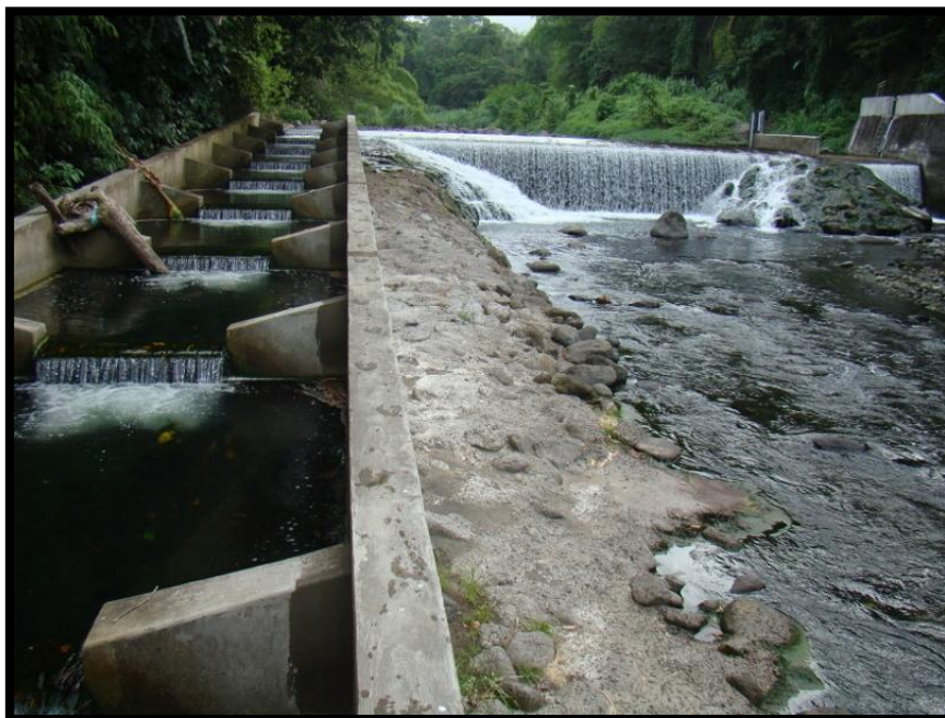
Ouvrage de franchissement piscicole de la prise d'eau potable de Vivé Capot
