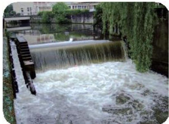
Avant arasement du barrage
