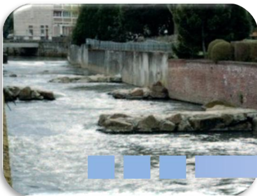
Après arasement du barrage
