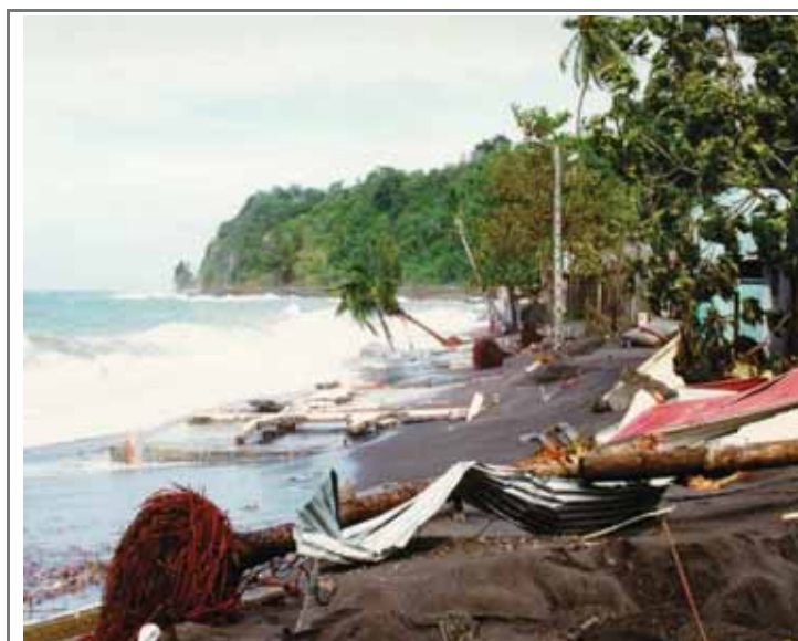
Illustration 12: Dégâts suite à submersion marine et houle cyclonique – Saint-Pierre, cyclone Lenny, novembre 1999 (source : DEAL Martinique)
