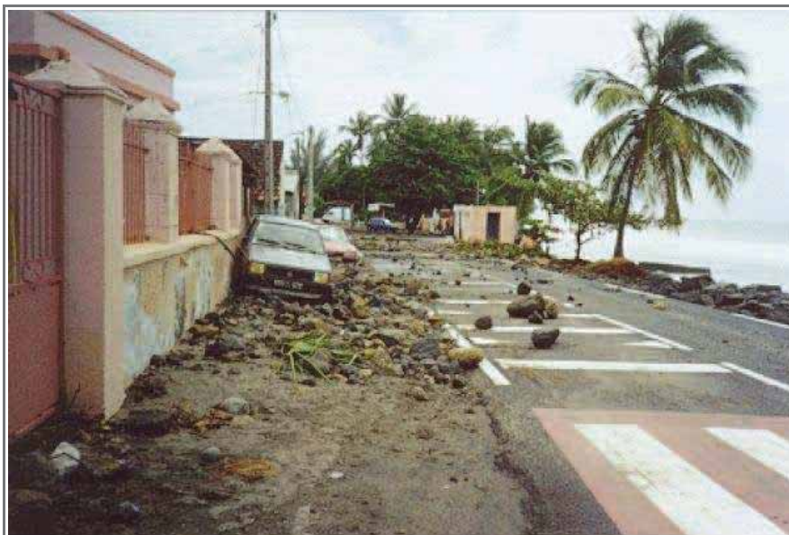
Illustration 21: Dommages au Carbet lors de l'ouragan Lenny (source : BRGM)
