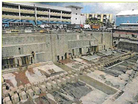
Figure 4 : Vue générale de l'intérieur du bassin – Partie nord (SAFEGE)
