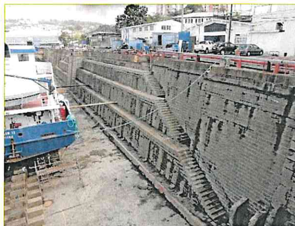
Figure 5 : Vue générale de l'intérieur du bassin – Partie sud (SAFEGE)
