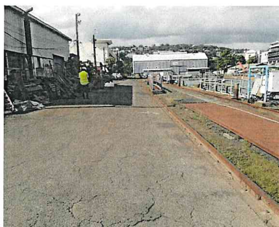
Photo 1 : Rails à l'ouest de la forme de RADOUB (Source : Suez consulting, Novembre 2020)
