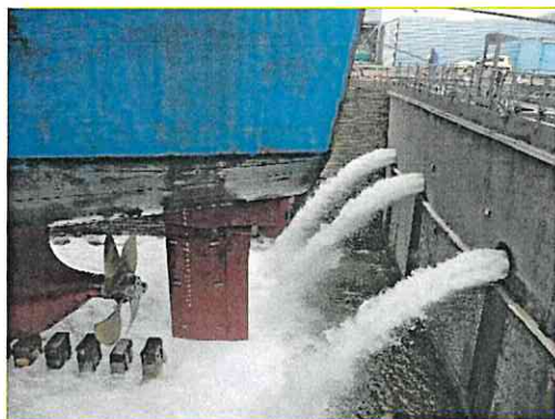
Figure 11 : Opération de mise en eau du bassin (04/06/15 - SAFEGE)
