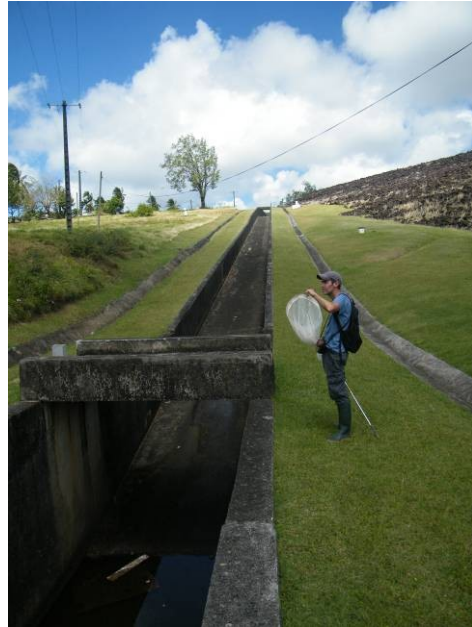
Canal déversoir de la Manzo
