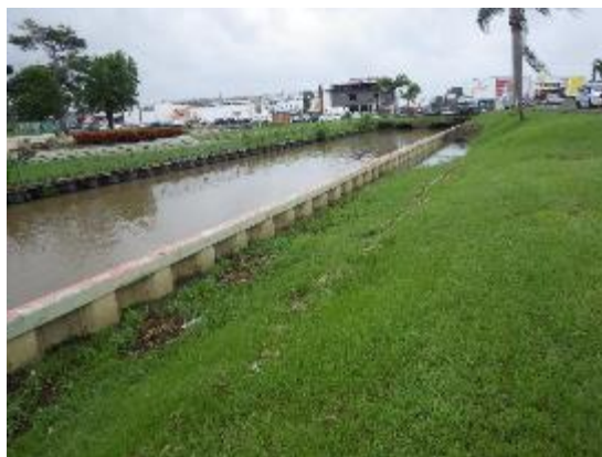
29/09/16 10h38 : quelques dizaines de cm séparent l'eau du sommet des palplanches à l'amont du rond-point du centre commercial (DEAL)
