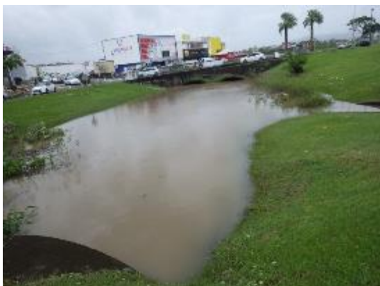
29/09/16 10h39 : les buses sous le rond-point du centre commercial sont presque noyées (DEAL)
