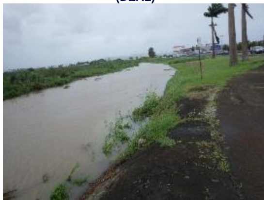
29/09/2016 10h35 : à l'aval, près du Palais des Sports, le Canal est haut mais dans son lit (DEAL)
