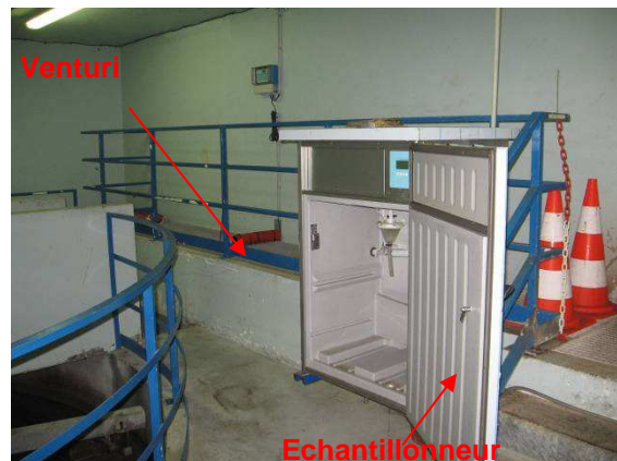
Poste de reprise
