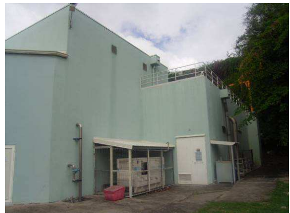
Vue de la station d'épuration (SCE – Novembre09)
