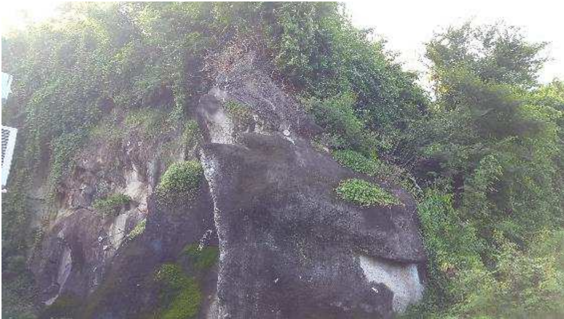
Figure 45. Dispositifs de sécurisation mis en place sur la falaise (Safege : Visite du 13/10/2016)
