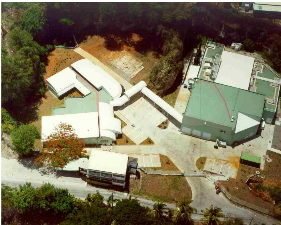
Vues aériennes de la station d'épuration de Schoelcher – Pointe des Nègres (CG97 - 2001)
