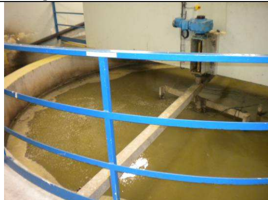
Ouvrage de Dessablage-dégraissage
