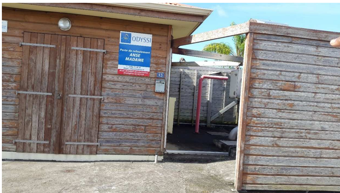
Figure 7. Poste de refoulement de l'Anse Madame (Safege : Visite du 13/10/2016)
