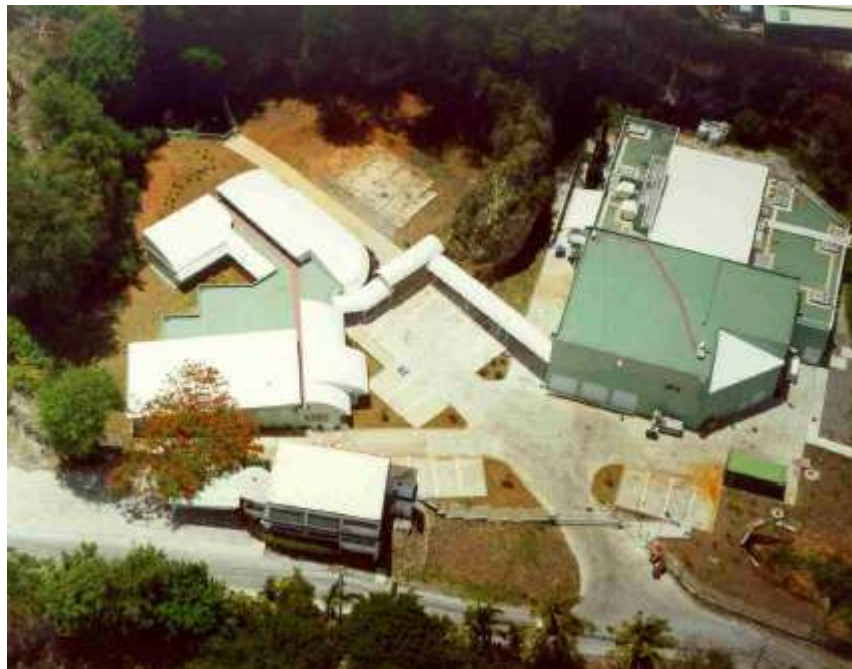
Figure 4. Vues aériennes de la STEU Pointe des Nègres (Audit SCE 2009)
