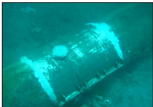
Demi-coquille en place, étanchée
