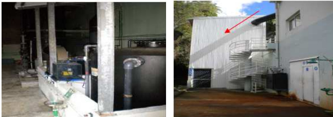
Figure 51. Unité de désodorisation (gauche) et local de désodorisation (droite)
