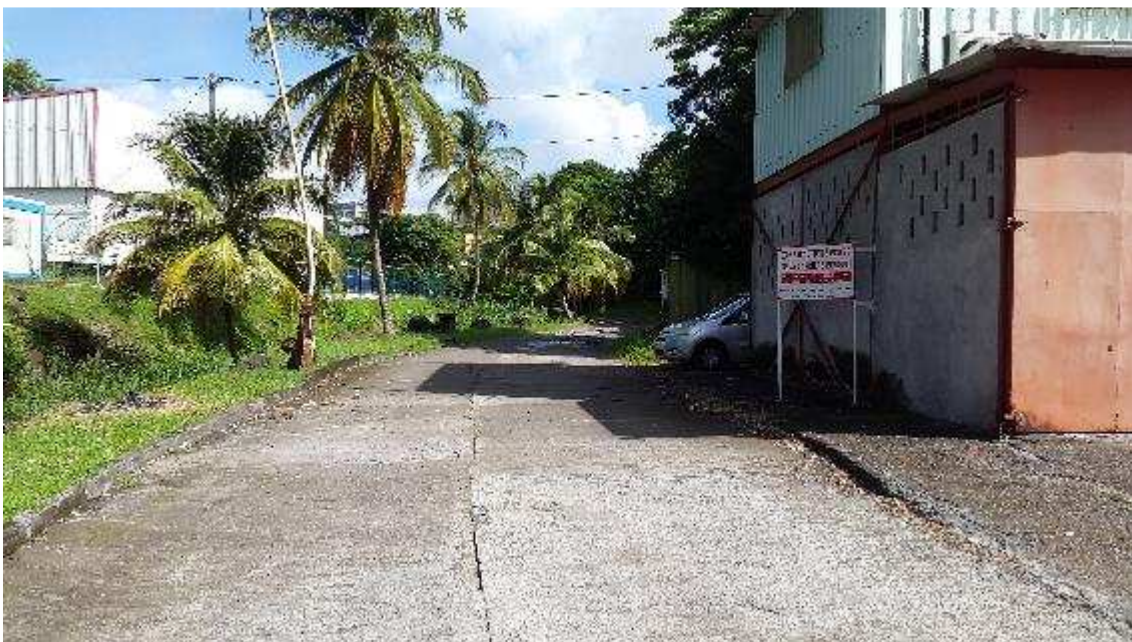
Figure 46. Entrée de la voie d'accès privée (Safege : Visite du 13/10/2016)
