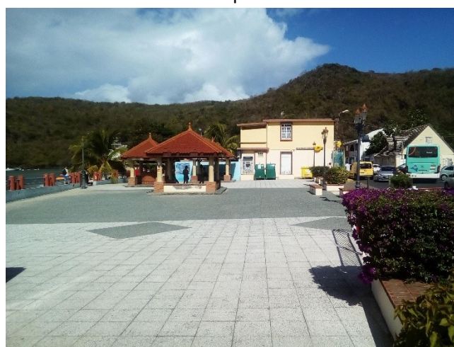
La 1 ère photo est une photo antérieure à l'aménagement. Les 3 autres photos ont été prises en 2019 plusieurs années après les travaux d'embellissement du front de mer.
